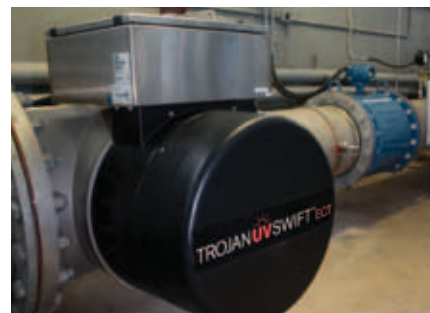
Figura 2. Il Comune di Cornwall, Ontario, Canada utilizza attualmente il TrojanUV Swift™ ECT per fornire tutto l'anno disinfezione primaria e la rimozione dei composti causa di variazione di sapore e odore durante gli eventi intermittenti di T & O con una portata di progetto di 26,4 MGD (4.164 m 3 / h).
